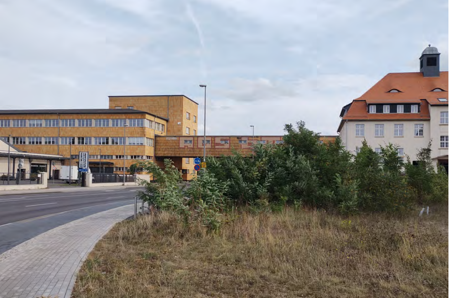
† Der ehemalige Postbahnhof mit der markanten Brücke als Übergang zum Paketverteilzentrum. Heute befindet sich in Teilen der Hallen ein Möbelgeschäft. (A. Reichstein)
